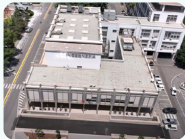
Aula Giuseppe Capito Dipartimento di Ingegneria, Viale delle Scienze, ed. 7 Palermo
